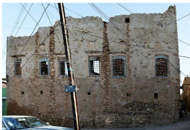
Fig. 16, Côté nord extérieur du bâtiment
