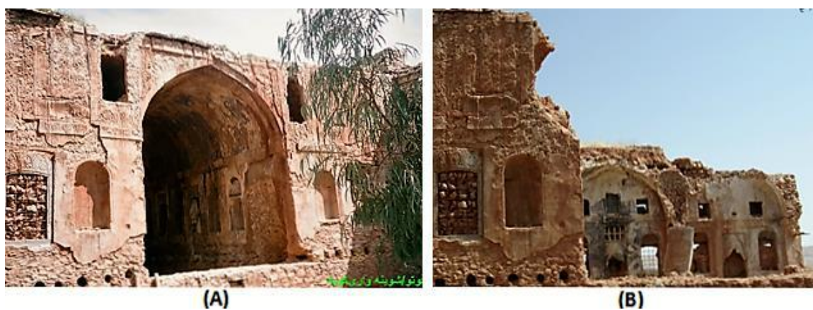
Fig. 17, (A) Premier étage en 2007, (B) Premier étage ruiné en 2014.
