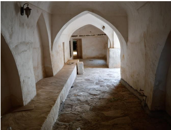
Fig. 20, Vestibule de la maison.
