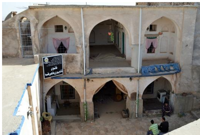
Fig. 26, La maison de ḥaġġī Ṭahā, côté sud.
