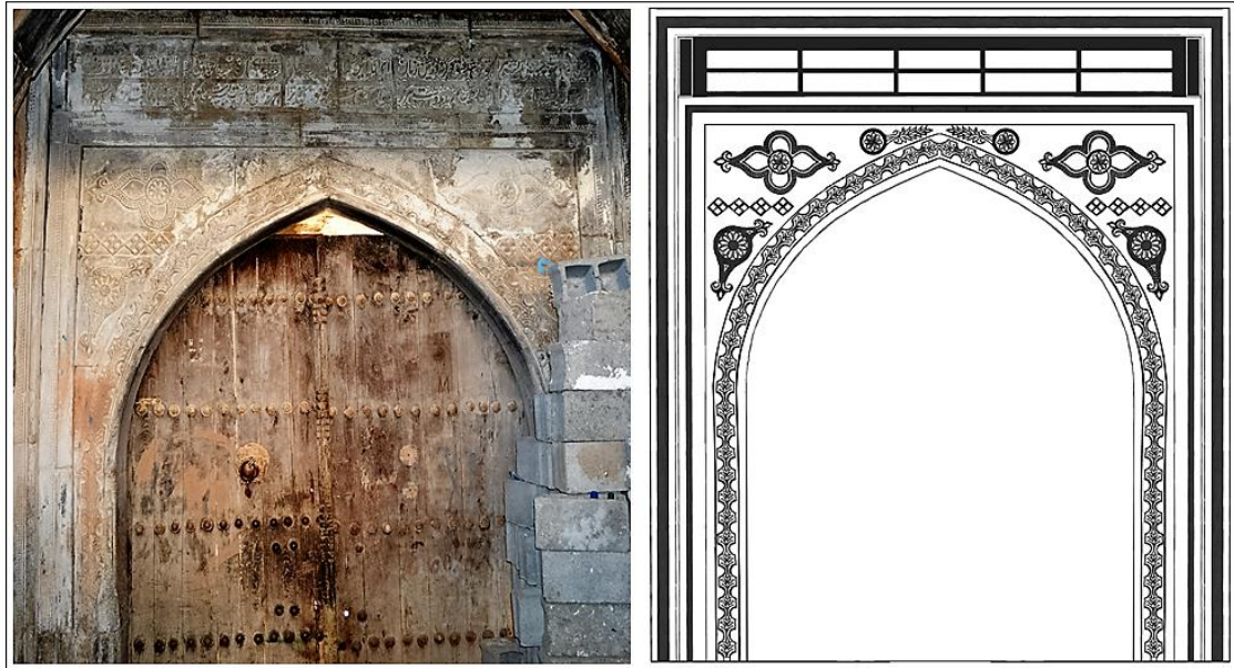
Fig. 57, porte principale du hān.
