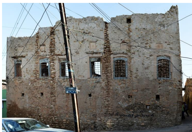
Fig. 16, Côté nord extérieur du bâtiment
