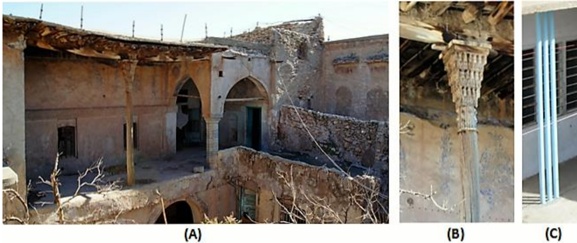
Fig. 30, (A) Colonnes de bois et marbre, (B) chapiteau surmontant la colonne en bois, (C) colonne de métal.
