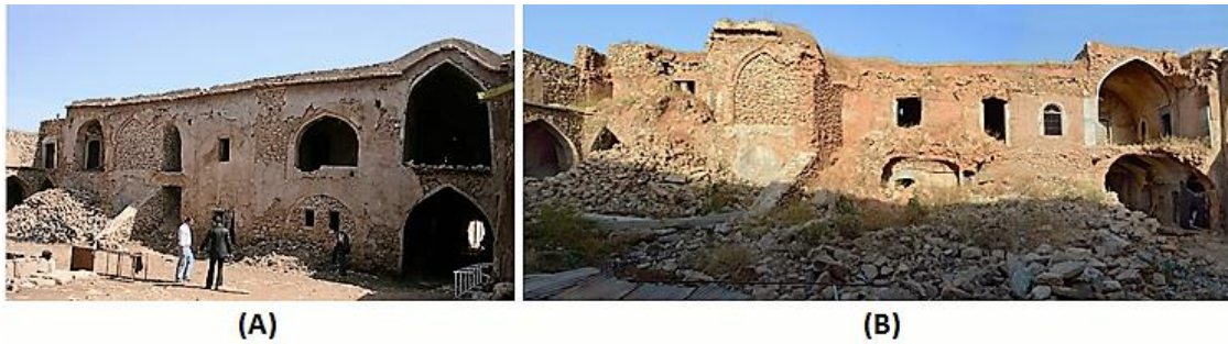
Fig. 7, (A) Le riwāq du côté sud-est en 2010, (B) état en 2015.
