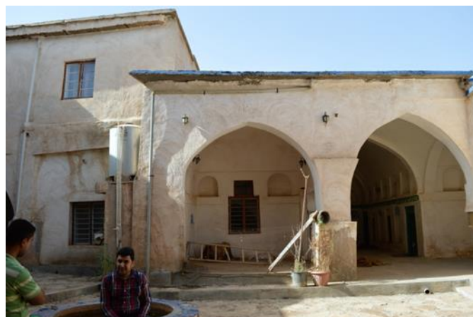
Fig. 21, La maison de ḥāǧǧī Ṭahā, côté nord et cuisine.
